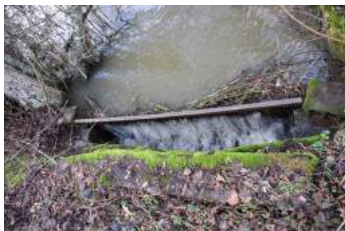
Détail de l'évacuation de l'étang.
