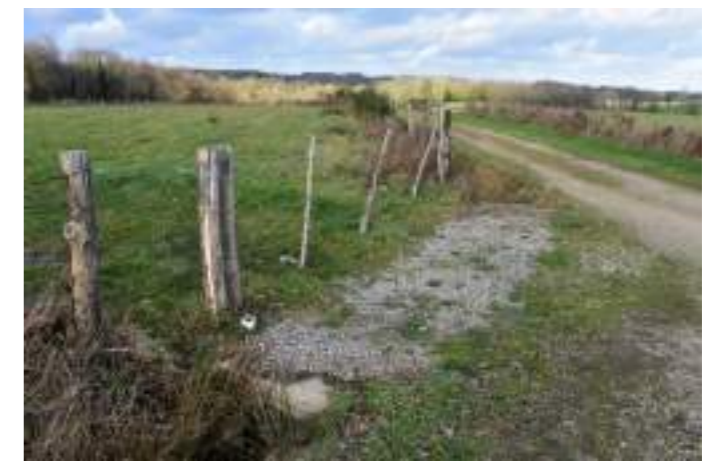
Accès à une parcelle busé.
