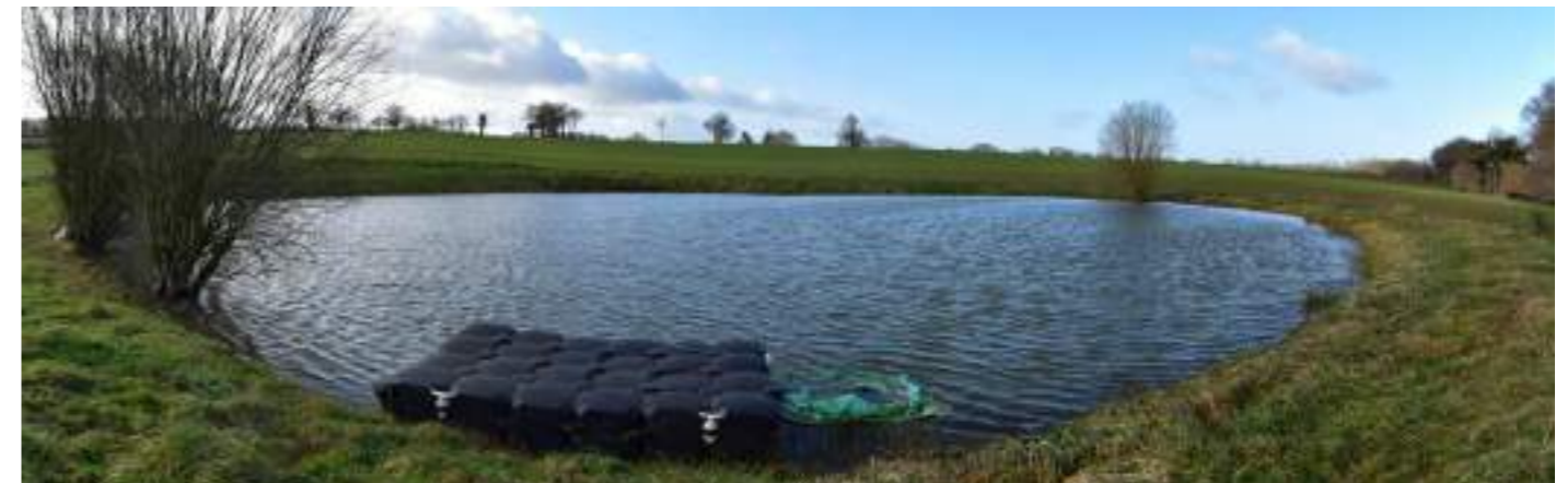
Vue d'ensemble de la réserve d'eau circulaire.
