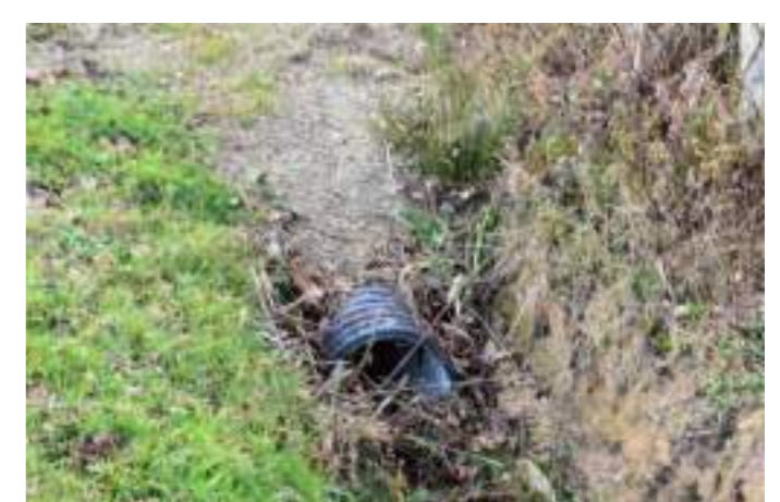
Détail du fossé et d'un accès busé.
