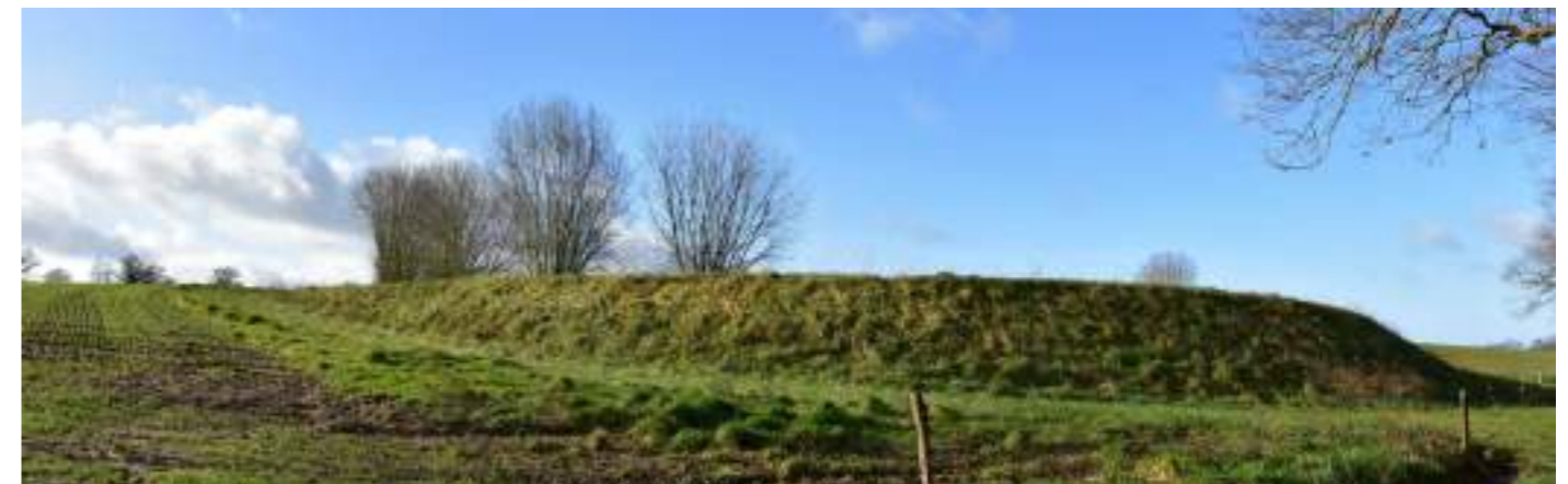
Réserve d'eau circulaire retenue par une levée de terre.
