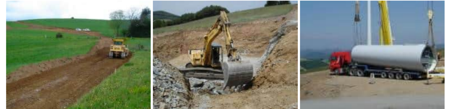
Photographie 193 : Illustration d'un chantier éolien
